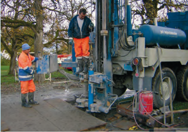
Einbau eines Grundwasser-Messrohres (Bohrung Steingass)
