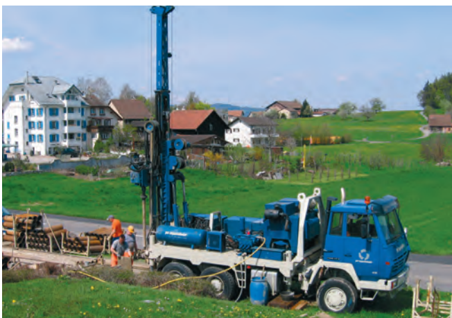
Bohrung Beichlen, Wädenswil
